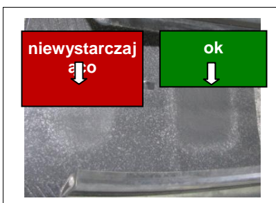
Rysunek 7 Czyszczenie powierzchni do przyklejenia
